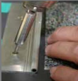
Das bereits vorgebohrte Grundprofil (Basisprofil) auf den Unterboden (z.B. Estrich) mit den beiliegenden Dübeln und Schrauben oder mit Montagekleber (z.B. Powergrip) befestigen.
