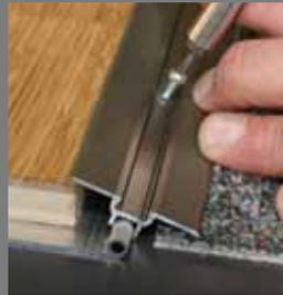
Das bereits ebenfalls vorgebohrte Deckprofil auf das Grundprofil je nach Neigung aufsetzen, fest niederdrücken und mit beiliegenden Schrauben fixieren.
