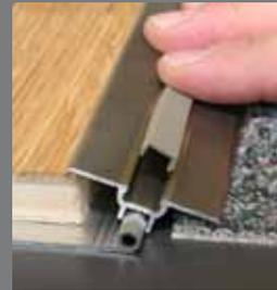
Abdeckprofil mit den Rillen nach oben in den Schraubenkanal eindrücken, um die Schrauben abzudecken.
